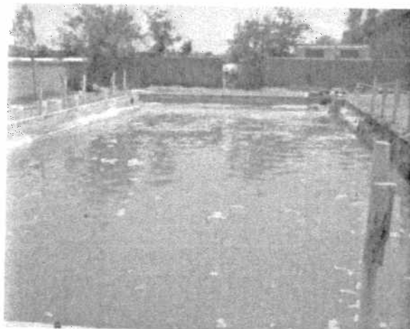
Ouagadougou, Traitement des Effluents à la tannerie
